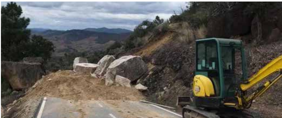
Remoção de bloco de pedra no talude da EM630, estrada que liga os Codeçais à Brunheda
